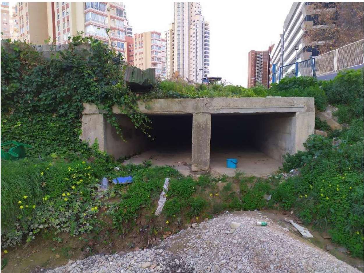
Imagen 8. Comienzo del encauzamiento mediante marcos en la Av. del Almirante Bernat de Sarria
