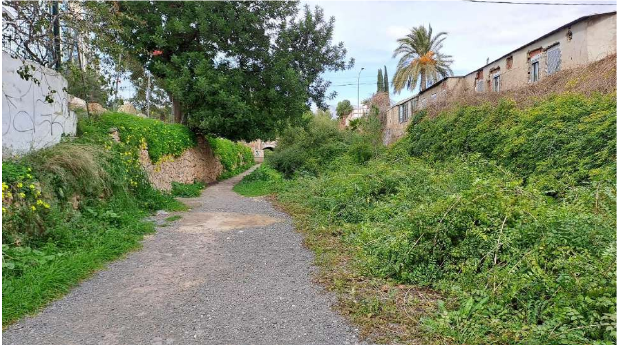
Imagen 55. Camino peatonal aguas abajo del puente que cruza la Av. de la comunidad Valenciana
