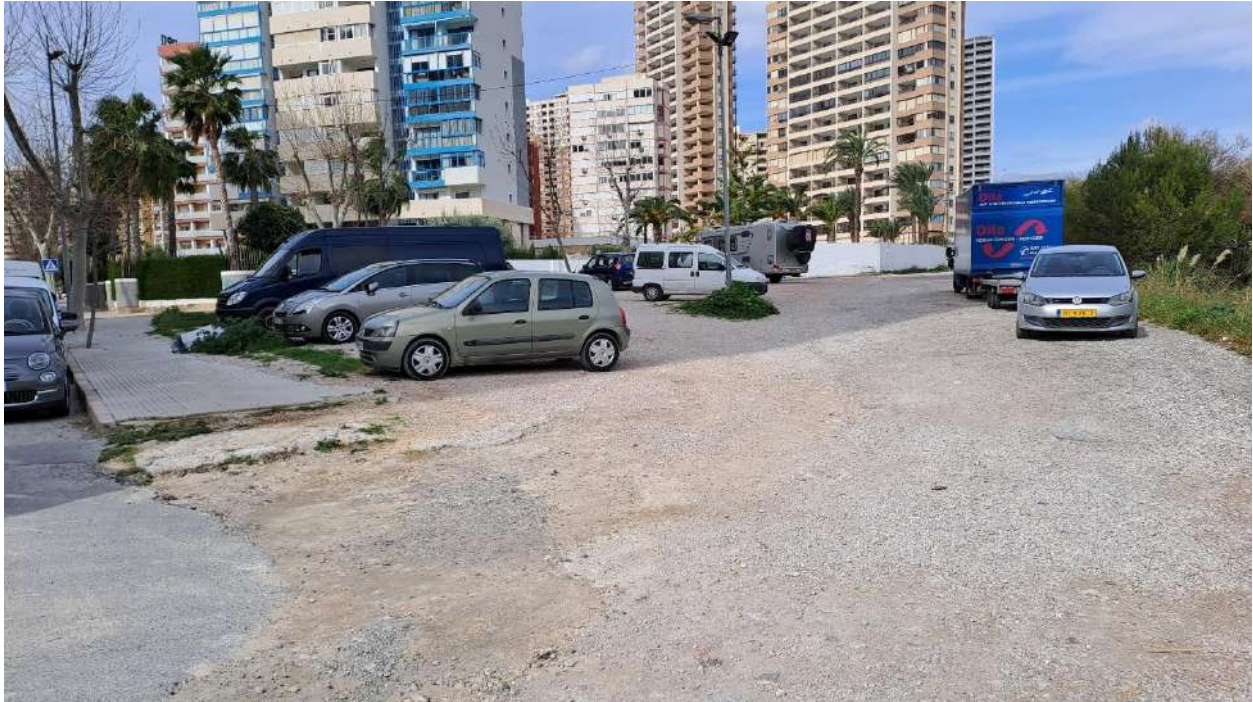
Imagen 45. Estado del cruce de la calle Derramador con la calle Kennedy
