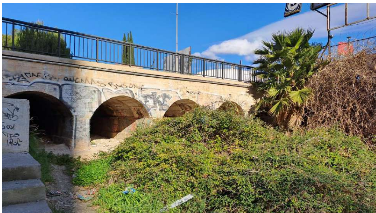
Imagen 3. Estado del puente del barranco Lliriet aguas abajo
