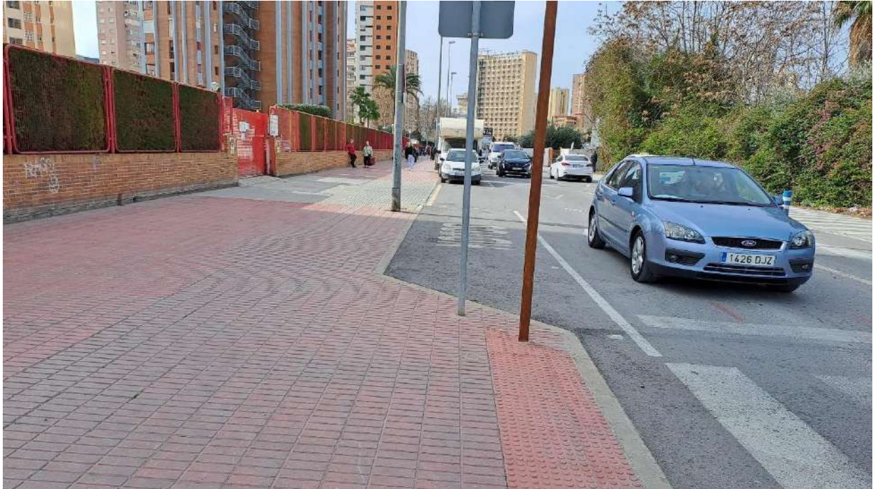
Imagen 37. Esto de la acera con la calzada. Pinte +0 cm en todo su recorrido
