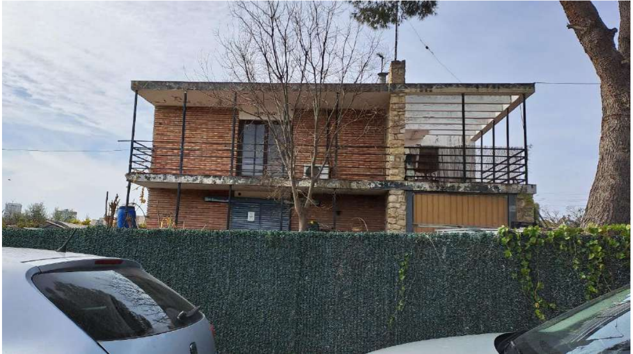
Imagen 19. Casas residenciales existentes a lo largo de la calle Armanello
