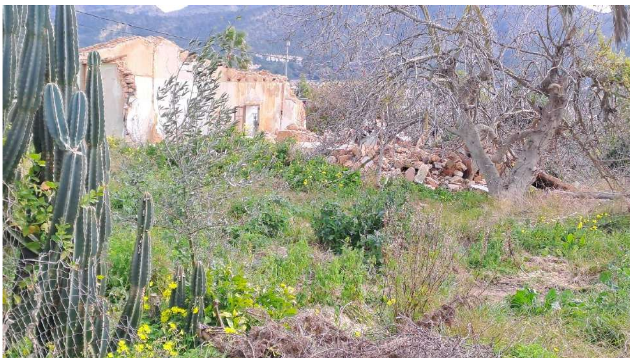
Imagen 24. Estado de las casas semiderruidas
