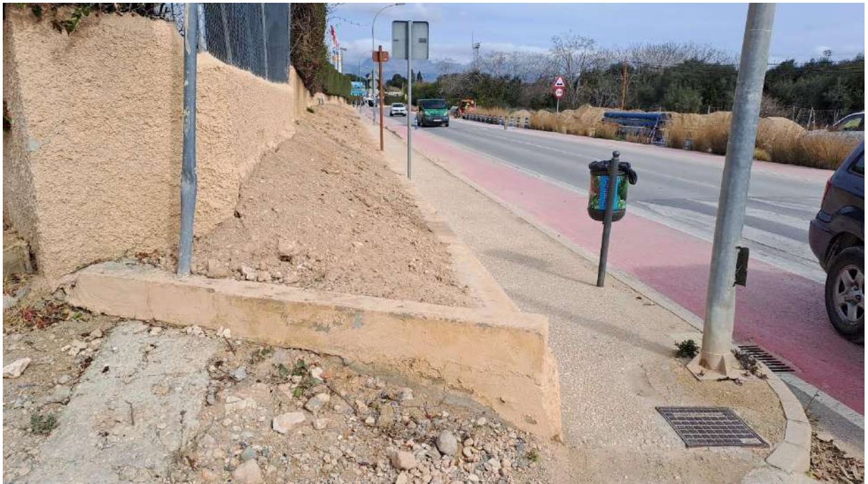
Imagen 30. Desnivel existente entre el camping Villasol y la Av. de Bernat de Sarria.
