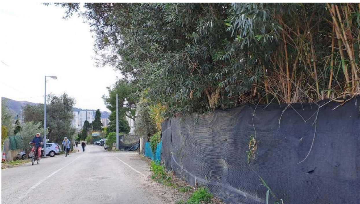
Imagen 18. Estado actual de la calle Armanello.
