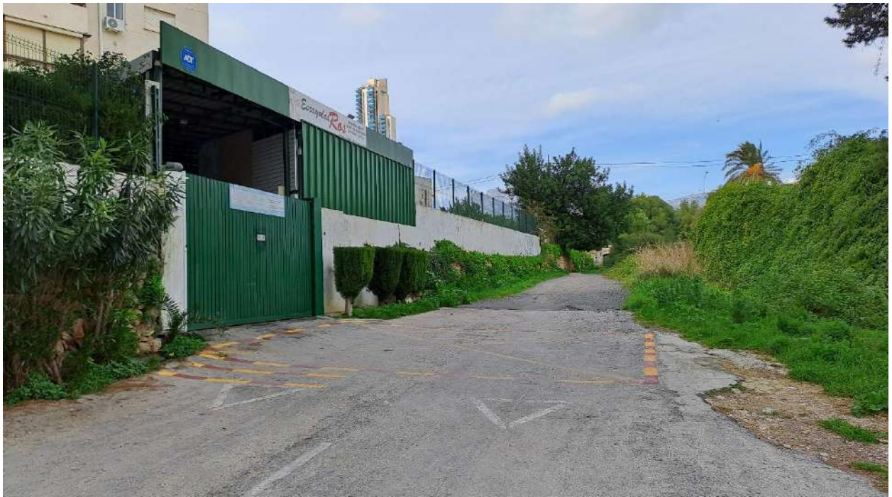
Imagen 54. Vado existente del edificio gemelos 10
