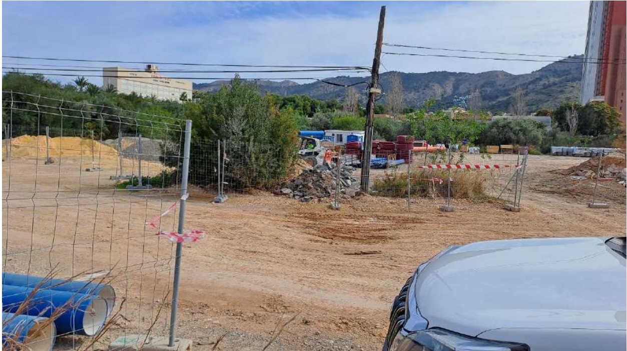
Imagen 31. Zona de acopio de obra próximas al sector. Posible zona de acopio de materiales.
